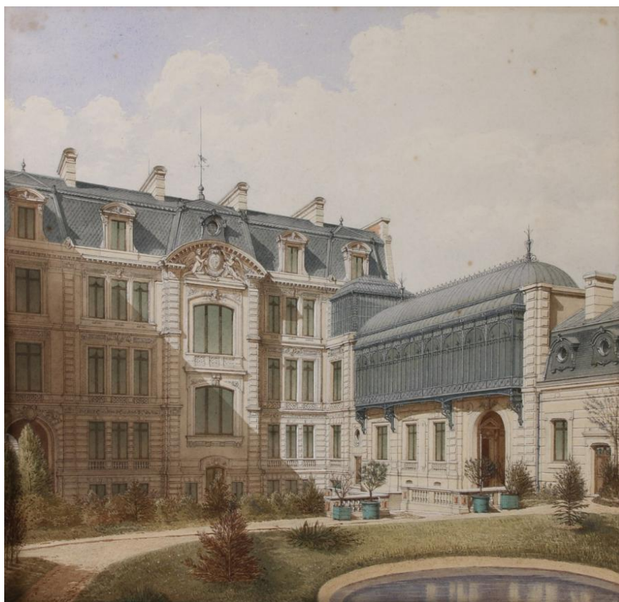
S33 - L'hôtel CAIL en 1870 – Façade sur jardin (source : château des Ricordières)
