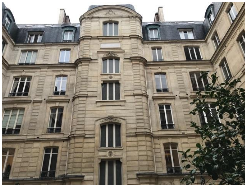
S37 - Cour intérieure du 52 – 54 boulevard Malesherbes ; Jean-François CAIL a fait graver ses quatre vertus cardinales sur le fronton du 4 e étage : TRAVAIL, INDUSTRIE, COMMERCE, AGRICULTURE
