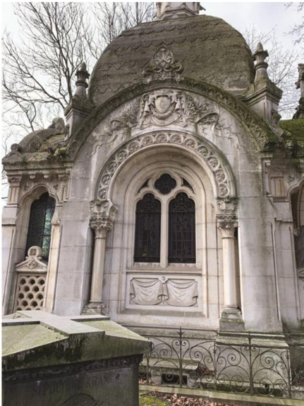
Façade gauche du mausolée ; à gauche se trouve une porte en pierre permettant de descendre les cercueils dans la crypte sans passer par la chapelle.
