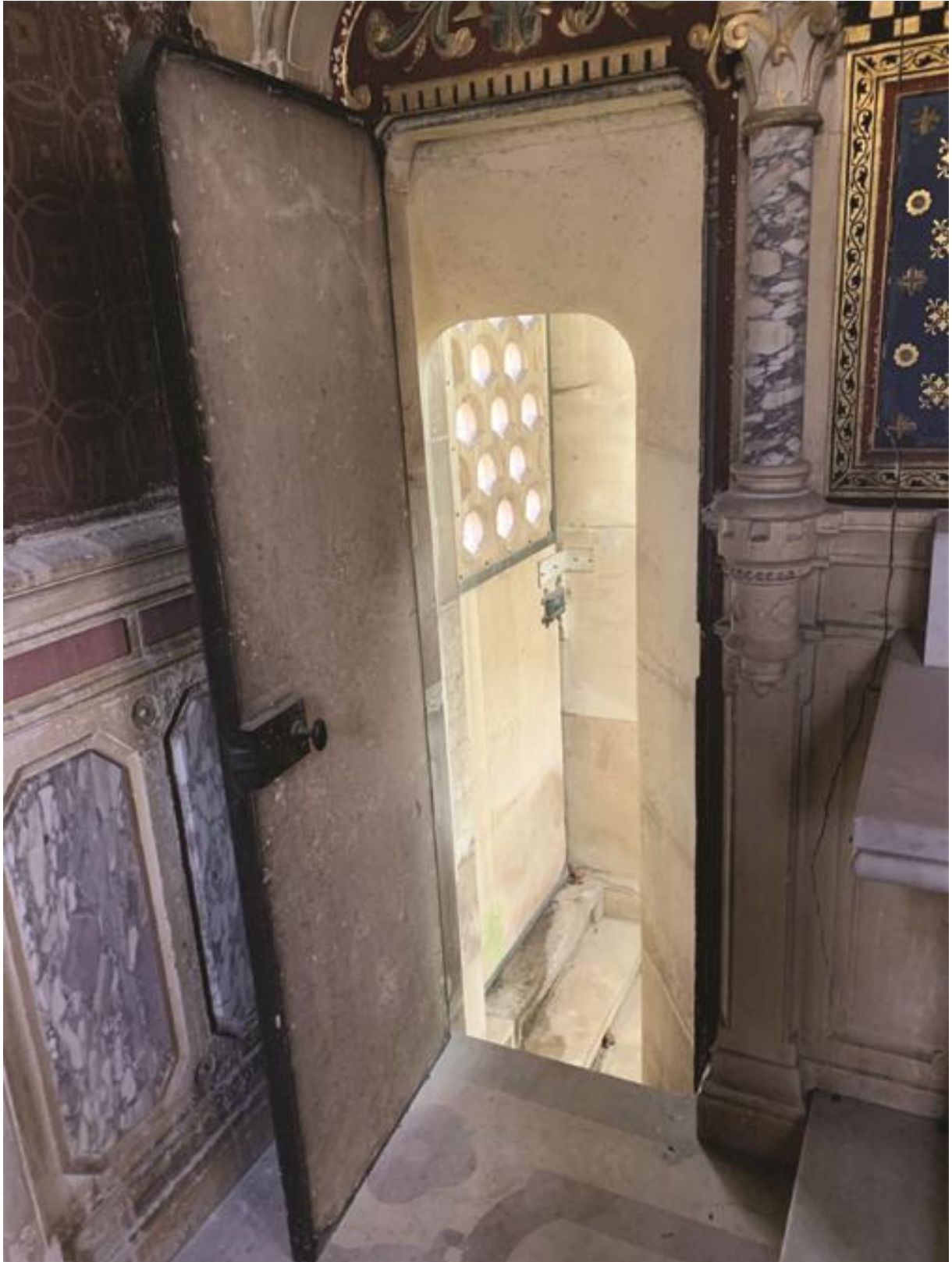
Le haut de l'escalier menant à la crypte.
